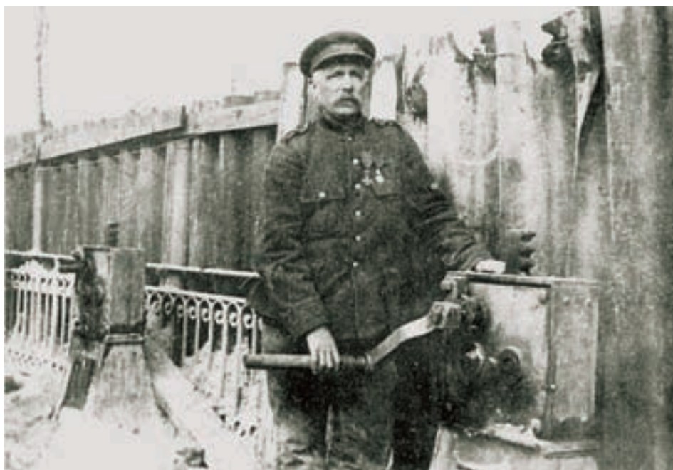
Hendrik Geeraert pose près de l'un des crics permettant de manoeuvrer le déversoir du canal Noordvaart (Collection Callanaere-Dehouc)
