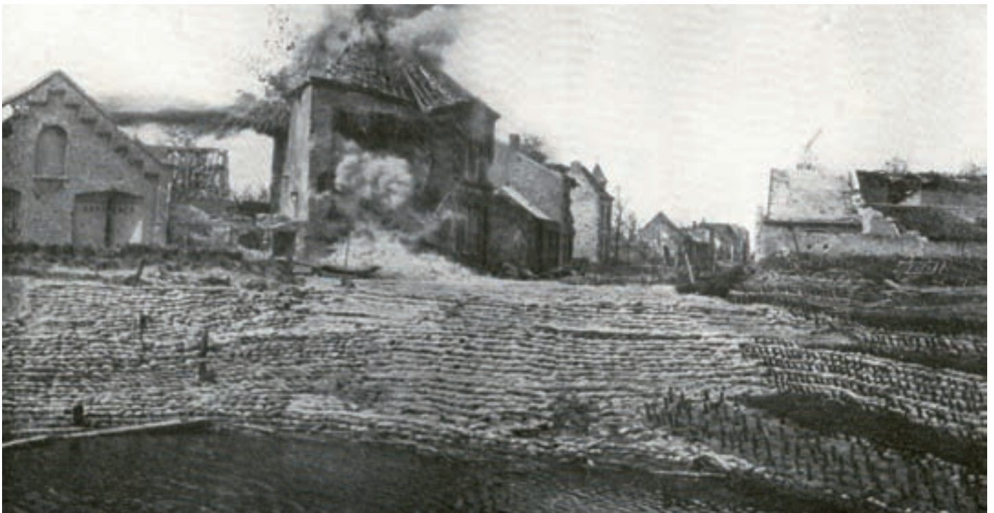
■ Un barrage de secours sur le canal Nieuport-Dunkerque au moment d'une explosion de bombe (Kristof Jacobs, Nieuwpoort Sector 1917)
